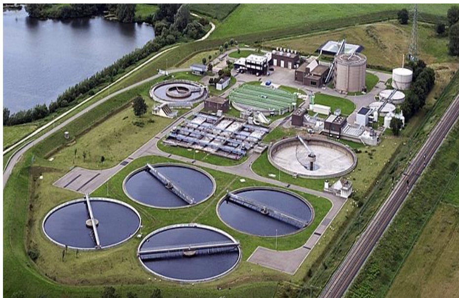
Slika 3 – Postrojenje za prečišćavanje otpadnih voda
